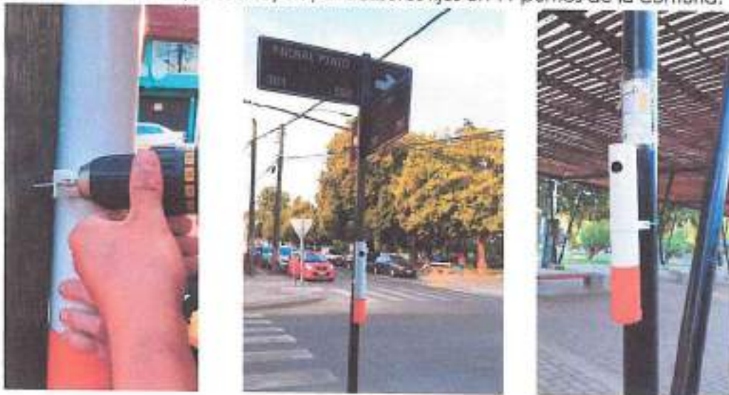
Imagen 55: Sustitución e instalación de Colleros oficiales
