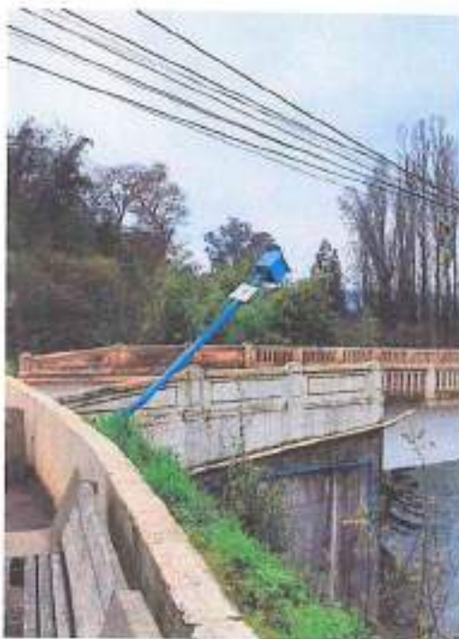
Imagen 17: Estación DGA en río bureo en puente acceso norte de la ciudad de Mulchén
